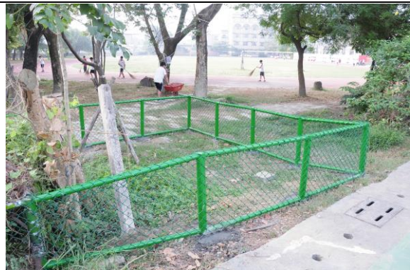
說明：堆肥區施工完成圖(二)
