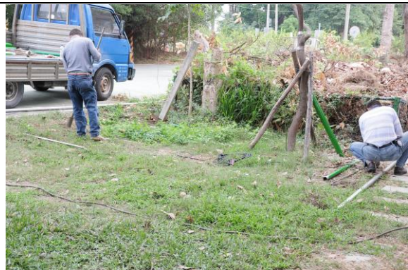
說明：堆肥區施工狀況。
