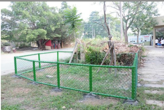
說明：堆肥區施工完成圖(一)
